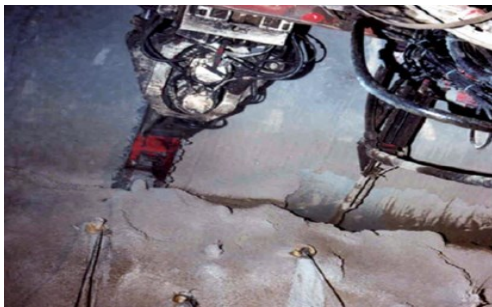
ب) عملیات پیش‌برش و تزریق همزمان
