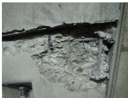
شکل ۱- پله‌شدگی و لب‌پریدگی در سگمنت‌های نصب شده در تونل
