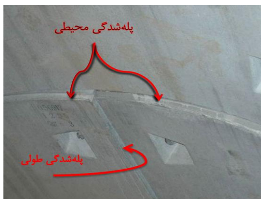
شکل ۱- پله‌شدگی و لب‌پریدگی در سگمنت‌های نصب شده در تونل
