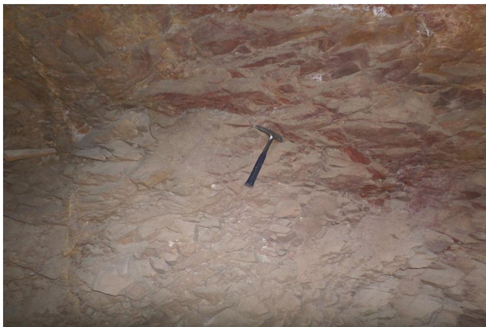
شکل ۳- وضعیت درزه داری دیواره تونل (درزه داری زیاد)
