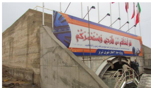
شکل ۹ - عبور موفق ماشین حفار و سر باره اجرا شده
