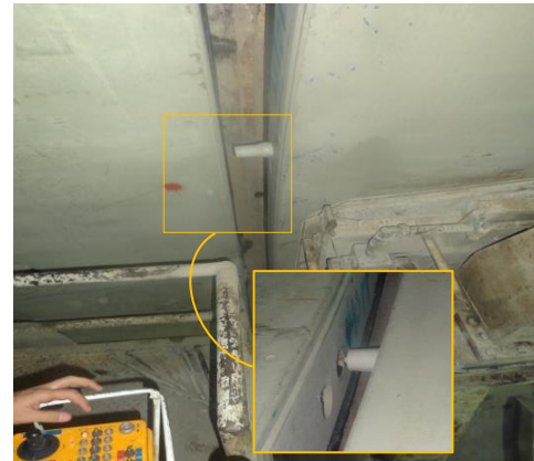
شکل ۲۳- مرحله نصب سگمنت تغییر یافته تیپ A به سگمنت تیپ B
