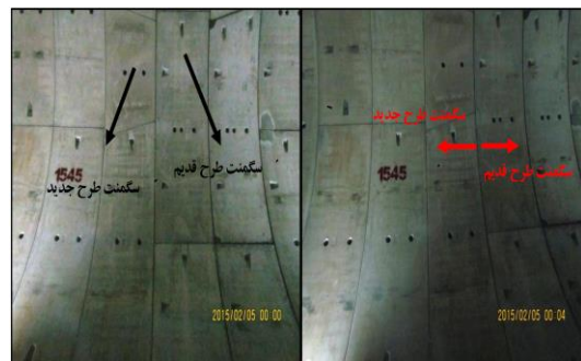
شکل ۷- سگمنت تیپ‌های مختلف نصب شده در تونل
