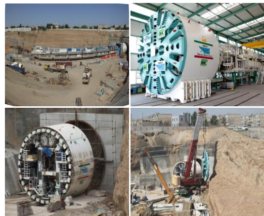
شکل ۳- تصاویری از دستگاه حفاری EPB و مراحل مونتاژ آن در خط ۶ متروی تهران
