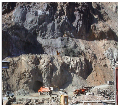
شکل ۱- مقطع حفاری تونل انحراف آب سد شهریار
