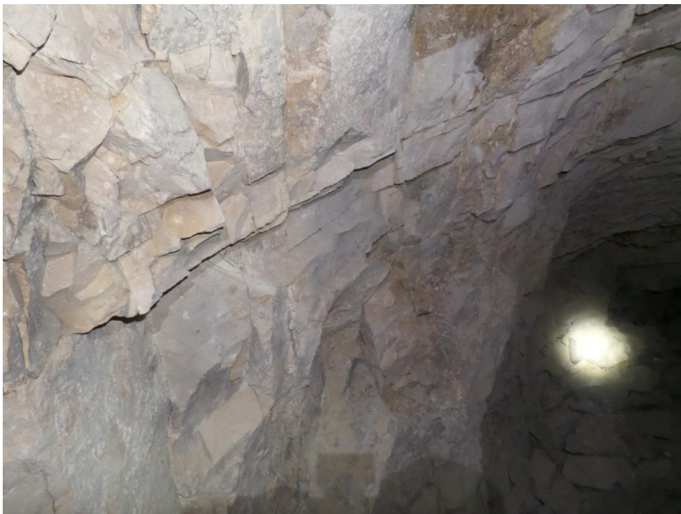
شکل ۱- وضعیت درزه داری دیواره تونل (درزه داری متوسط)
