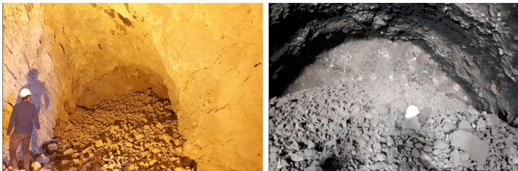
شکل ۳- توده‌ی خردشده بعد از انفجار در جبهه‌کار تونل
