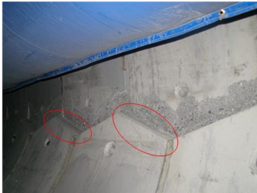
شکل ۱- نمونه‌های پله شدگی و انحراف هندسی خطای نصب سگمنت در تونل انتقال آب گلاب در مجاورت سد تنظیمی زاینده رود
