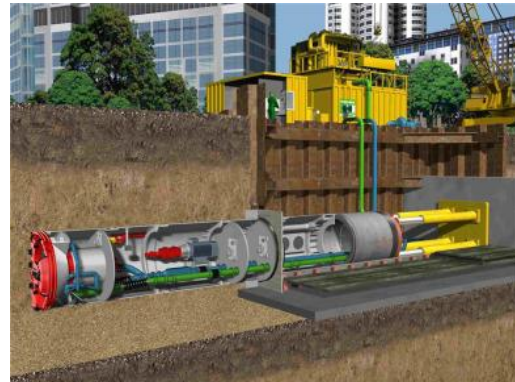
شکل ۱- روش میکروتونلینگ
