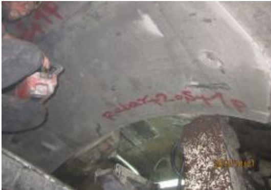
شکل ۲۶- سگمت‌های الیافی تحت بار جک‌های دستگاه حین نصب
