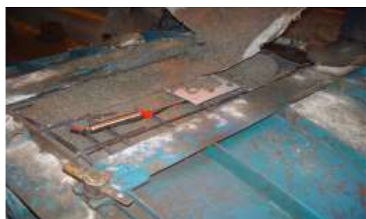
شکل ۱- سلول فشار مورد استفاده در پروژه گلاب ۲ زمان بتن ریزی داخل قالب سگمنت
